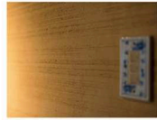
スイッチプレートは有田焼のもの。壁には色や質感のニュアンスが優れた西洋漆喰を採用
