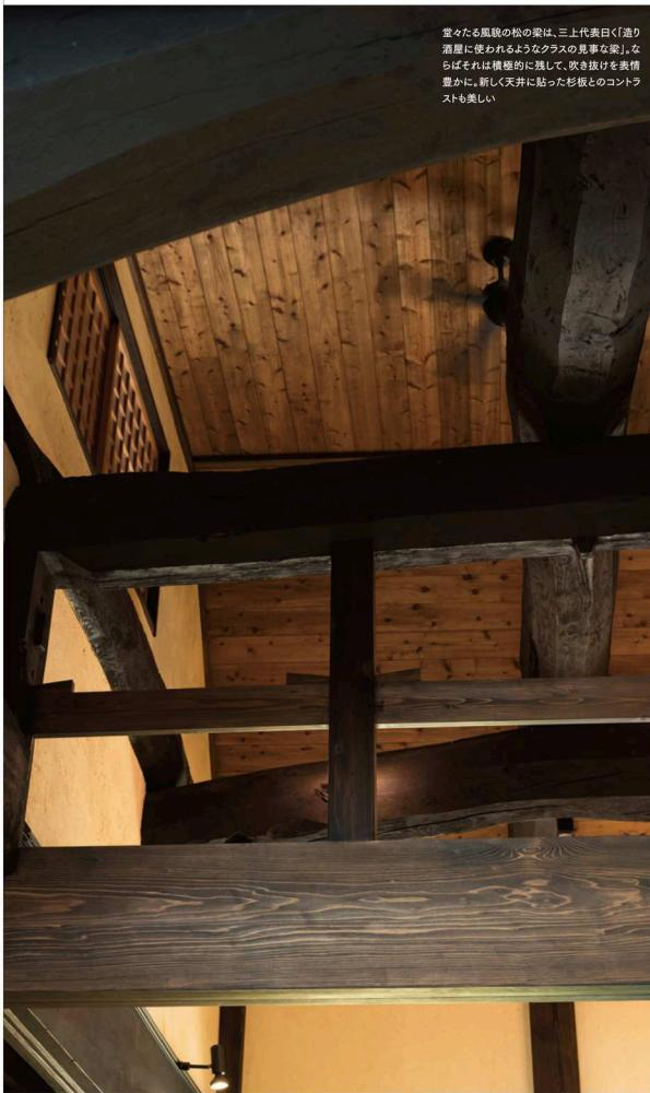
堂々たる風貌の松の梁は、三上代表曰く「造り酒屋に使われるようなクラスの見事な梁」。ならばそれは構造的に残して、吹き抜けを表情豊かに。新しく天井に貼った杉板とのコントラストも美しい。
