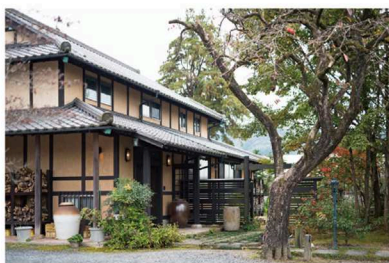
築90年以上の古民家だが、最新技術の新熱材やペアガラスを施し、寒さ対策は万全だ
