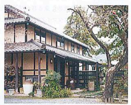
築90年以上の古民家だが、最新技術の断熱材やペアガラスを施し、寒さ対策は万全だ
