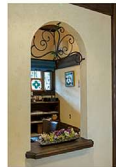
仕切り壁に施した、アール竣工の窓。視界が広がって、空間のアクセントとしても効果的。
