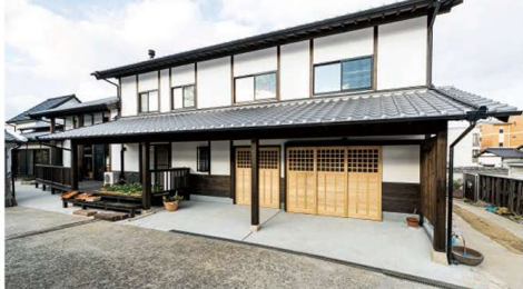
外観も全面的に改装。屋根は「いぶし瓦」に葺き替え外壁にも白いスペイン漆喰を塗装し、伝統的な雰囲気にもモダンな要素を加えた
