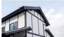
時間が経つほどに風合いが出る、スペイン漆喰。割れやひび割れも起こりにくい
