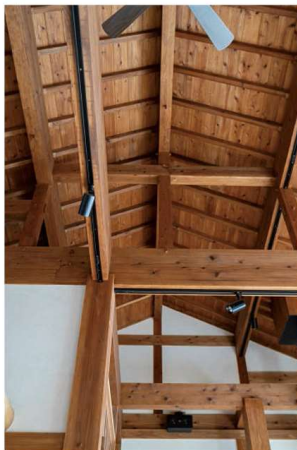
リビングは1階部分の天井を取り外し、開放的な吹抜けに。瓦と屋根の下にある野地板の間に断熱材を入れることで、屋根からの熱や寒さを防いで1年中快適に過ごせる
