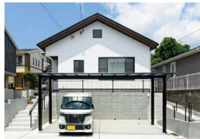
青空に映えるスペイン産の外壁はついた汚れが薄くなる自浄作用も兼ね備えている
