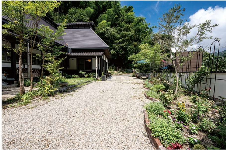
築150年ほどの木造家屋を、形と構造を残しつつ耐震補強や断熱性能を高め、安心かつ快適に暮らせる状態にリノベーション。緑豊かな山間にあるロケーションを活かすため、室内から外の景色を眺められるよう設計し、家にながら自然とつながりを感じられる工夫が凝らした。建物の内装仕上げや外壁、新たに設置した外観には、アルカリ成分が強く自浄作用のある天然のスペイン塗壁を用いている。
